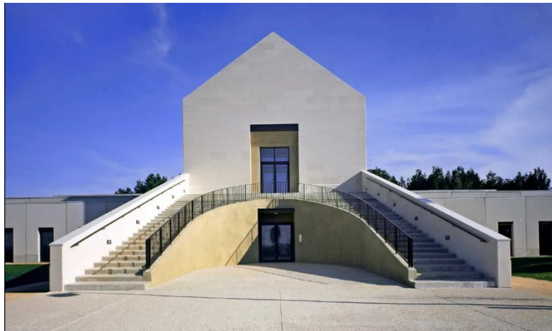
Le crématorium de Martigues
